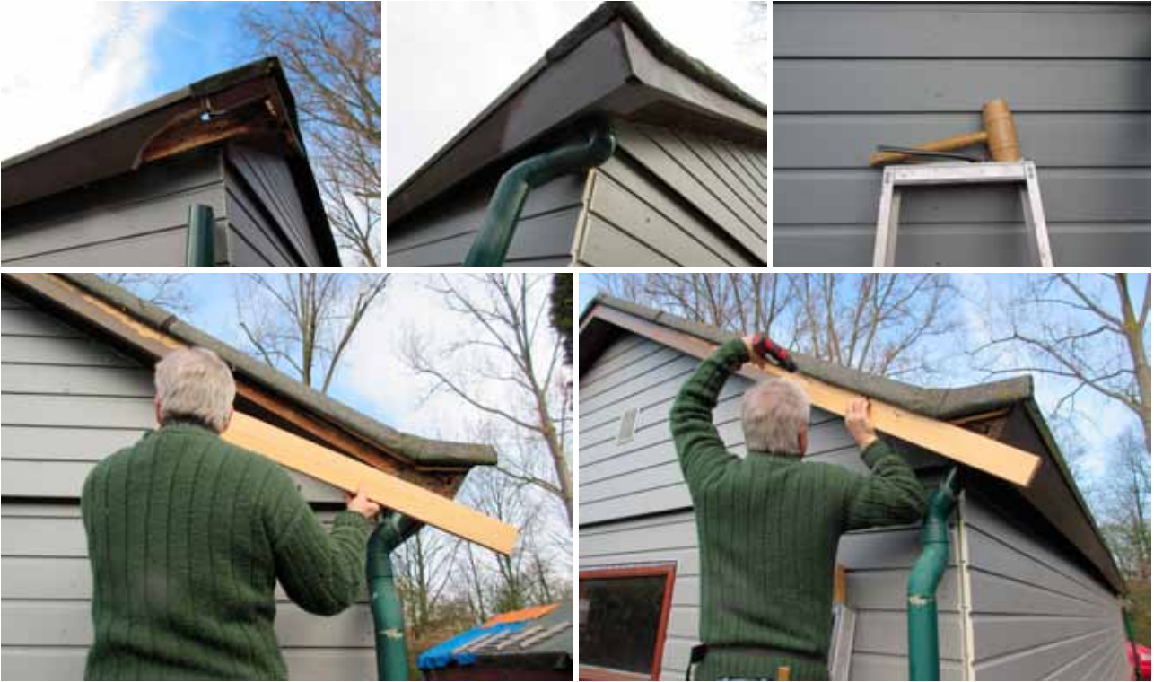
De timmerman doet het fijnere werk aan de buitenkant, het wegwerken van rotte plekken en zo.
